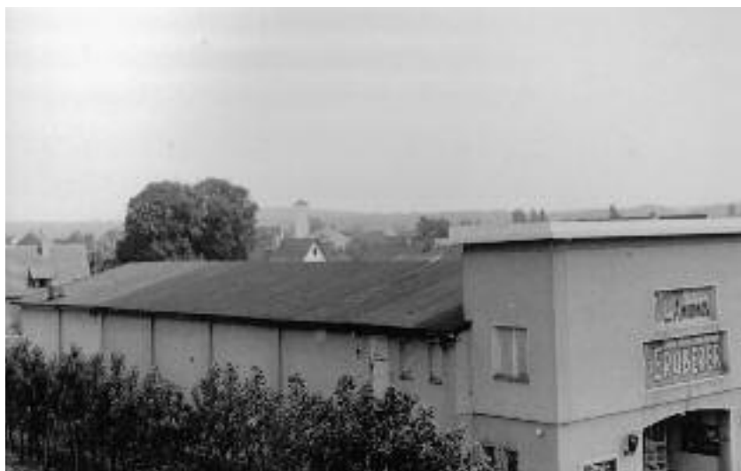
Bei dieser Seitenansicht der „Lintorfer Lichtspiele“ erkennt man an der helleren Farbe die Erweiterung der Halle im hinteren Bereich
