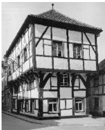
Das alte Fachwerkhaus „Im roten Hahn“ (heute Suitbertus-Stuben) an der Ecke Oberstraße/Turmstraße
