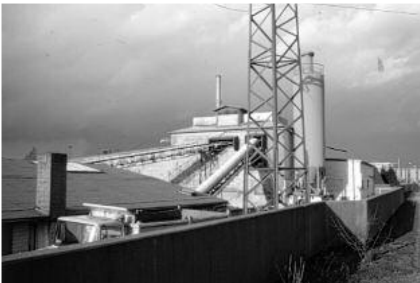
Das Bausteinwerk Dr. Blasberg und Co. (Kalsiton) im Jahre 1988
