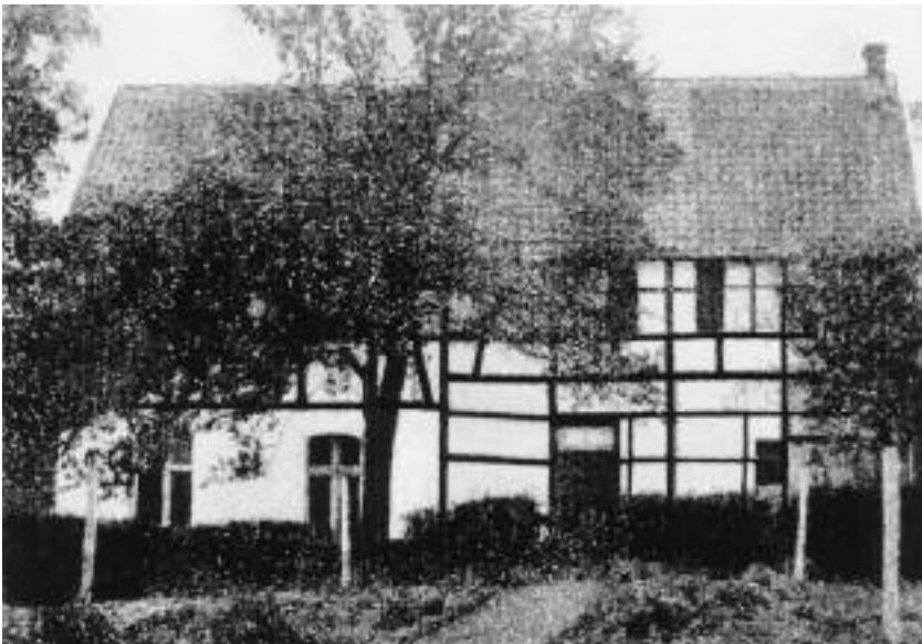
Die unterste Schule nach dem Ausbau Der Fachwerkteil (rechts) ist das uralte Hobshäuschen Der linke Gebäudeteil mit den großen Fenstern im Erdgeschoß wurde ausgebaut
