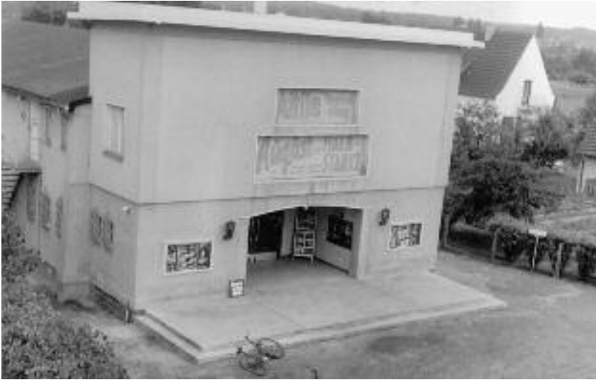
Die „Lintorfer Lichtspiele“ in den 60er Jahren. Der Eingangsbereich wurde aufgestockt. An der Seite erkennt man die eiserne Treppe, die zum Vorführraum hinaufführte
