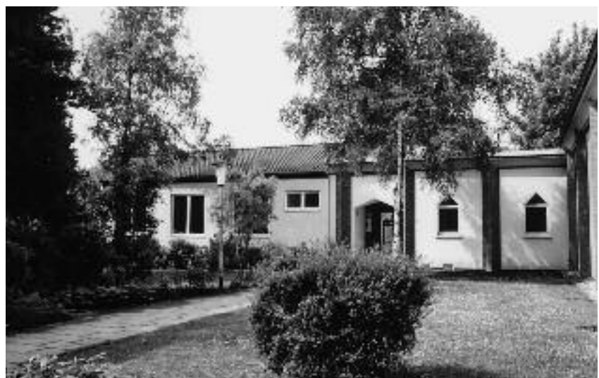
In der Bildmitte der vom Architekten Karl Granderath 1928 errichtete erste Kindergarten der St. Josefskirche in Eckamp. Links davon der nach dem Zweiten Weltkrieg gebaute kleine Pfarrsaal
