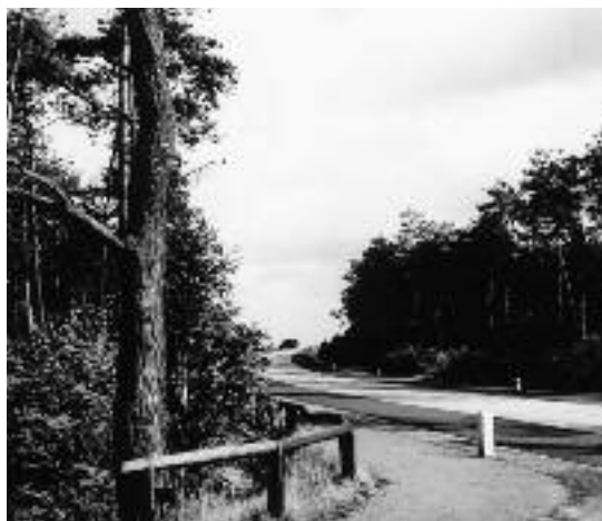
Der „Nördliche Zubringer“, die B1 zwischen Düsseldorf und der Autobahn A3, vor ihrem Ausbau zur heutigen A52
