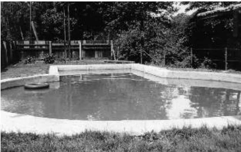
Aus dem Fundament eines ehemaligen Gasometers wurde ein rundes Schwimmbad für die Familie und die Belegschaft der Fabrik. Später wurde ein viereckiges Nichtschwimmerbecken angebaut
